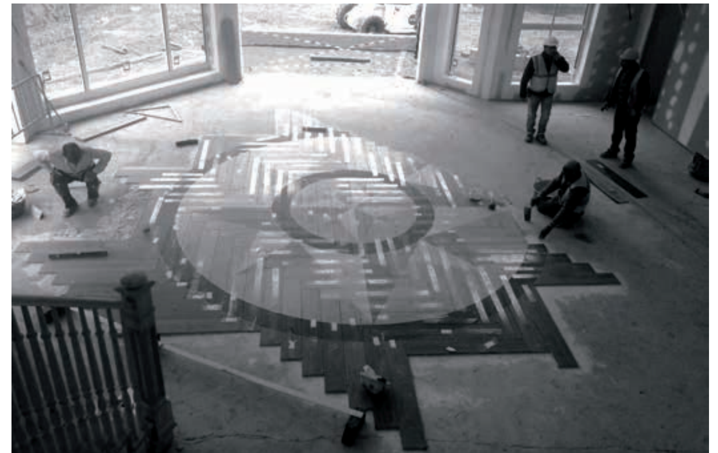
Colocación pavimento / Flooring installation
